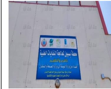
الأعمال الكهروميكانيكية محطة نفايات بسيون
