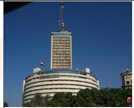
الأعمال الكهروميكانيكية وتأمين التغذية الكهربائية بمحطات كهرباء مبنى ماسبيرو
