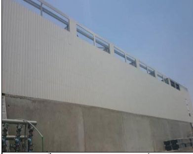
الأعمال الكهروميكانيكية تلاجات الهايكستب
