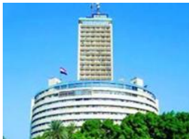
تأمين التغذية الكهربائية مبنى الإذاعة والتلفزيون
